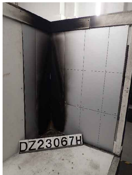
Foto 8: Prüfkörper DZ3.1/23-067H („K-300“), Ansicht nach der Prüfung.
