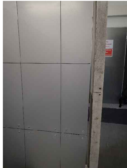
Foto 2: Prüfkörper DZ3.1/23-067G („K-300“), Detailansicht der Außenkante des breiten Probenflügels in Höhe von 500 mm in einem Winkel von ca. 45° vor der Brandprüfung.
