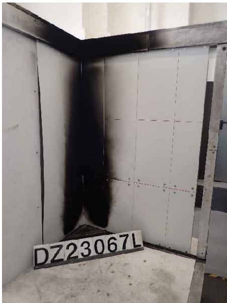
Foto 23: Prüfkörper DZ3.1/23-067L („K-300“), Ansicht nach der Prüfung.
