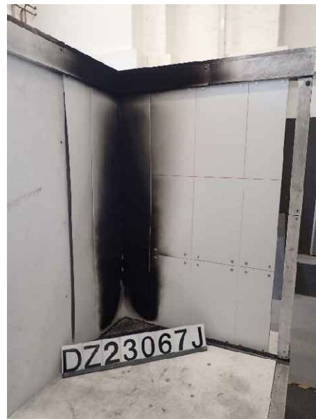
Foto 16: Prüfkörper DZ3.1/23-067J („K-300“), Ansicht nach der Prüfung.
