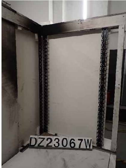
Foto 13: Prüfkörper DZ3.1/23-067W („Tragschienen universal aus Aluminium“), Ansicht des großen Flügels vor der Brandprüfung.
